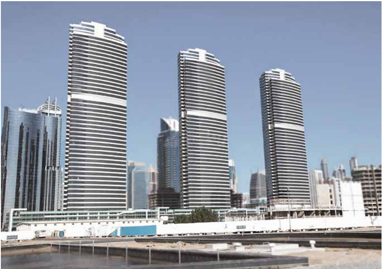
Mazaya Residence in Dubai Für ein Höchstmaß an Sicherheit: Komplette Ausstattung mit 1.200 Notleuchten, abgesichert durch eine batteriegestützte Stromversorgungsanlage.
