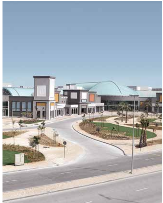
Deira Water Front Market in Dubai Komplette Ausstattung des Fischmarktes mit 2.000 Notleuchten. Die Absicherung erfolgt über eine batteriegestützte Stromversorgungsanlage.
